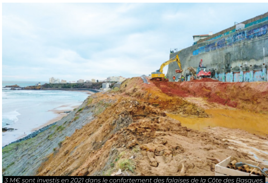
3 M€ sont investis en 2021 dans le confortement des falaises de la Côte des Basques.
