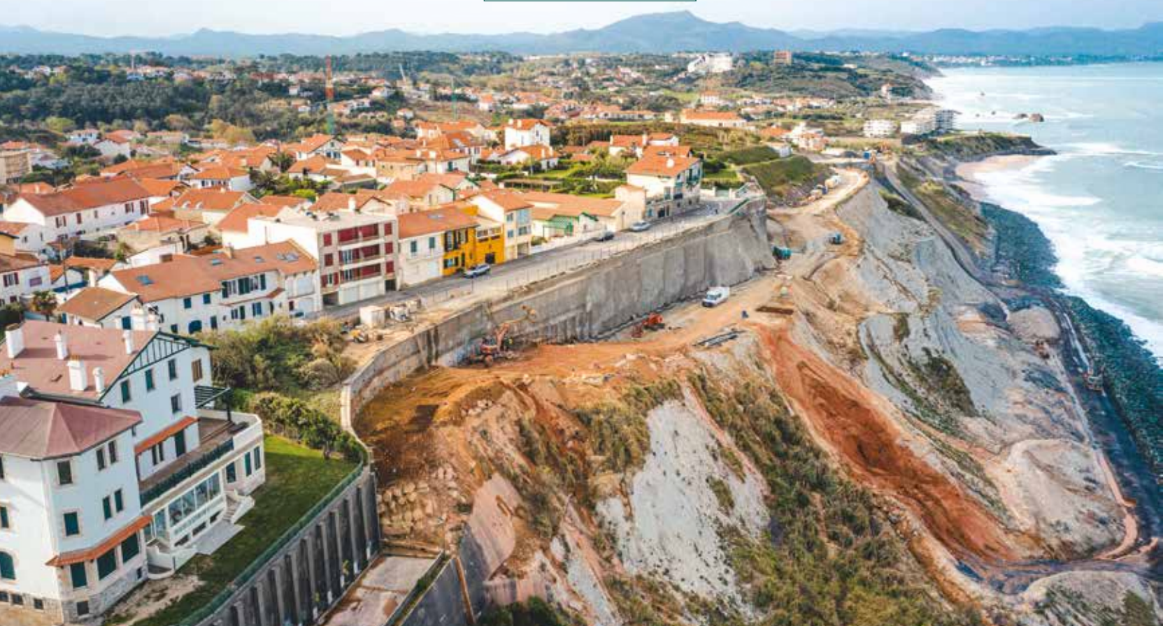
Le chantier portait sur 150 m linéaires de parois et 320 m en pied de falaise.
