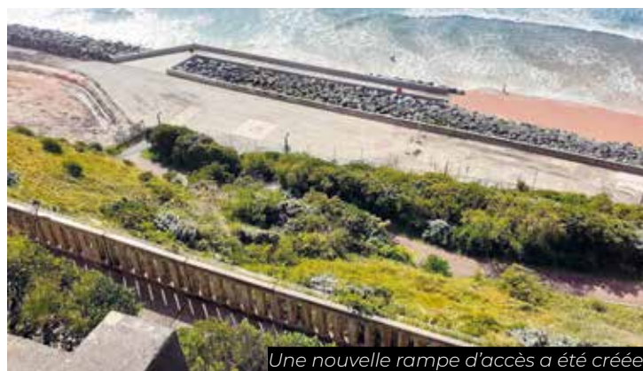
Une nouvelle rampe d'accès a été créée.
