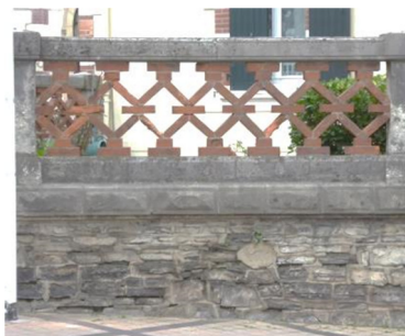
Rue des Falaises Beurivage Mur plein, en pierres moellonnées, toute hauteur et couronnement
