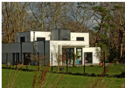
Architecture à toit plat en secteur naturel
