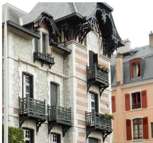
L'architecture maçonnée est parfois dotée de bacons en bois ; le barreaudage et les consoles peuvent présenter un aspect décoratif.
