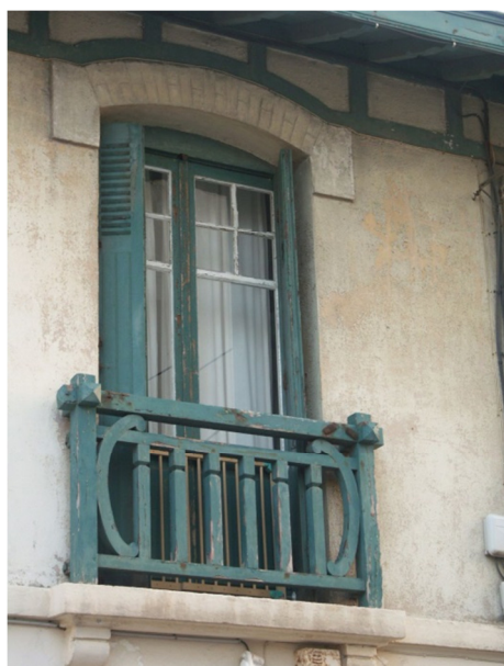
Garde corps en bois souligné par une saillie du bandeau maçonné.
