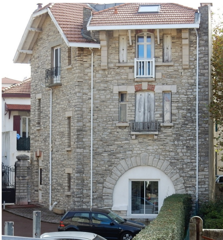
L'écriture architecturale s'appuie sur trois parements : Moellon éclaté de pierre grise, pierre blanche taillée surfacée, et brique de parement.
