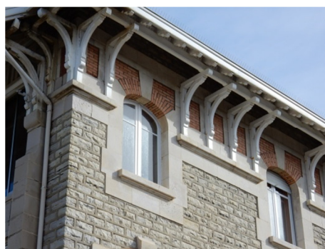
L'écriture architecturale s'appuie sur trois parements : Moellon éclaté de pierre grise, pierre blanche taillée surfacée, et brique de parement.
