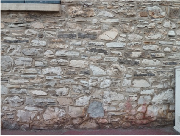
Moellonnages « assisés » destinés à être vus
