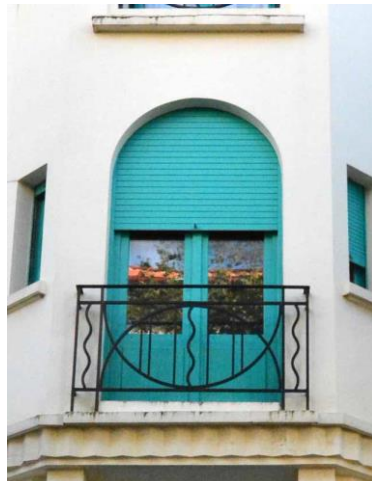
Le volet roulant se développe sur les immeubles de style Art-Déco ; le mécanisme et l'enrouleur sont à l'intérieur et les rails sont encastrés dans les tableaux de la baie.
