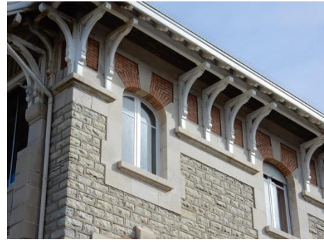
L'écriture architecturale s'appuie sur trois parements : Moellon éclaté de pierre grise, pierre blanche taillée surfacée, et brique de parement.
