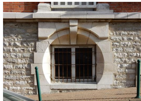
L'écriture architecturale s'appuie sur trois parements : Moellon éclaté de pierre grise, pierre blanche taillée surfacée, et brique de parement.
