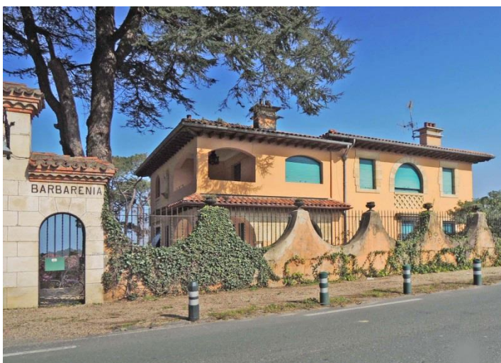
Villa Barbéréria – ici pavillon d'entrée
