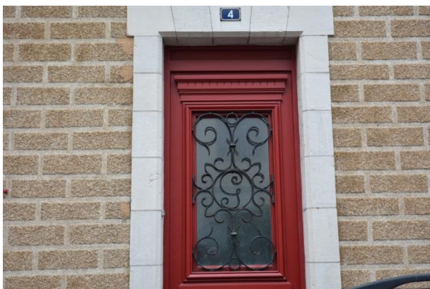
Enduit à fausse coupe de pierre
