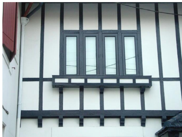
Fenêtres « en succession » : les baies sont incrustées exactement entre les bois
