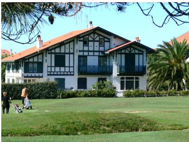
Façade néo-basque structurée par le graphisme des bois entre refends maçonnés
