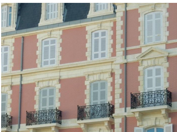
Enduit à décor fausse brique de parement
