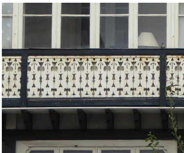
Barreaudage en planches jointives en bois découpé.
