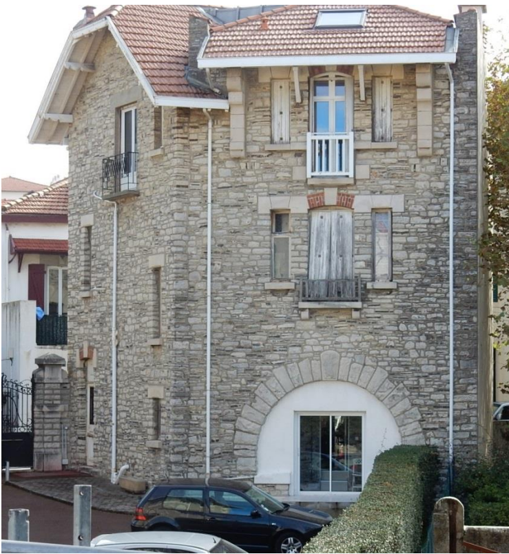
L'écriture architecturale s'appuie sur trois parements : Moellon éclaté de pierre grise, pierre blanche taillée surfacée, et brique de parement.
