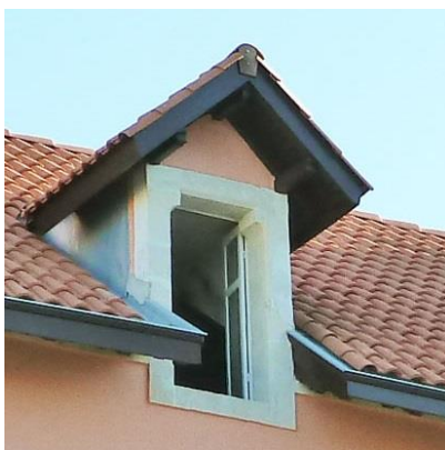
Lucarne passante de villa à deux pans
