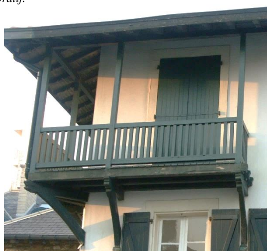
Le balcon à claire-voie peut se présenter sous la forme de simples barreaudages verticaux entre des lisses.
