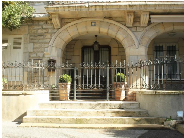
Portail en serrurerie d'un mur bahut ; la transparence de la clôture participe à l'apparat et laisse voir l'architecture
