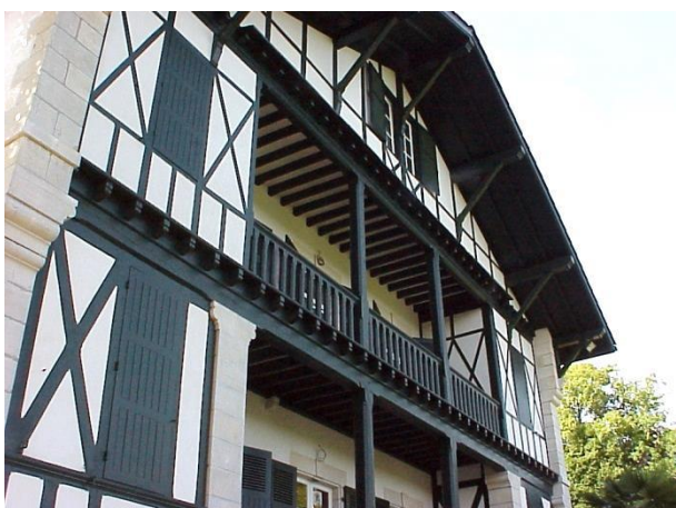
Le système du pan de bois est structurel : poteaux, poutres, solives, planchers charpente et balcons forment un tout
