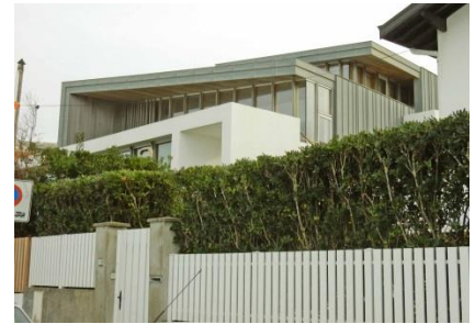
Composition de maçonneries et de bardages
