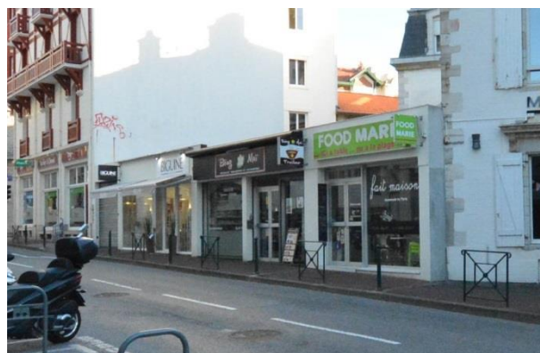
Série d'immeubles qui peuvent être remplacés, voire surélevés
