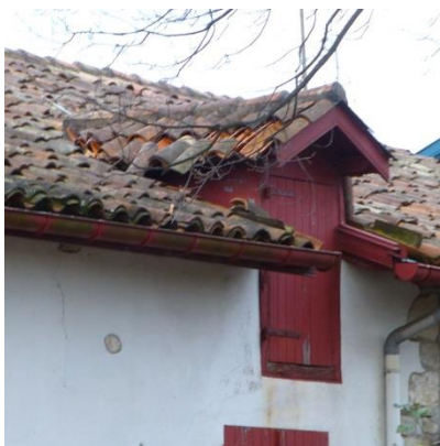
Lucarne passante rurale à deux pans. La prescription de couverture en tuiles canal exclut les tuiles à emboîtement à ondes (tuiles dont le courant et le couvrant sont d'un seul tenant).
