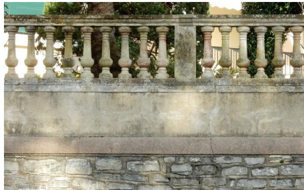
Allées Sapièha, Clôture sur soutènement, surmontée de balustres
