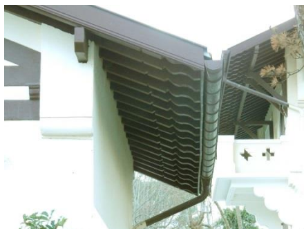
Débord de toiture, rue du Brésil
